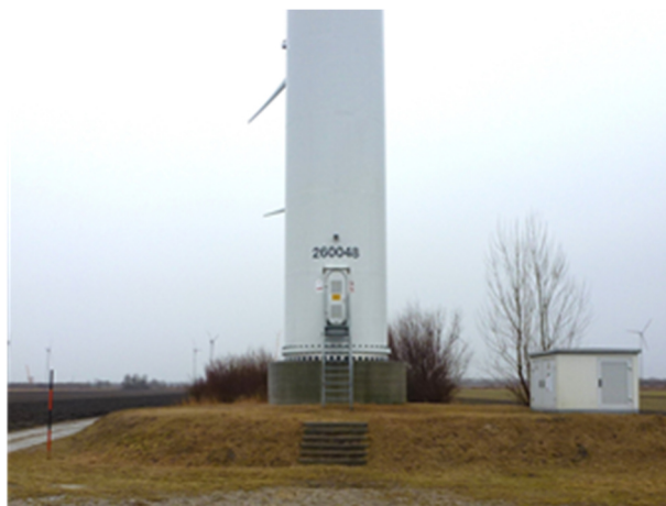
Abbildung 10: Überschüttete Fundamentplatte und Transformatorstation
