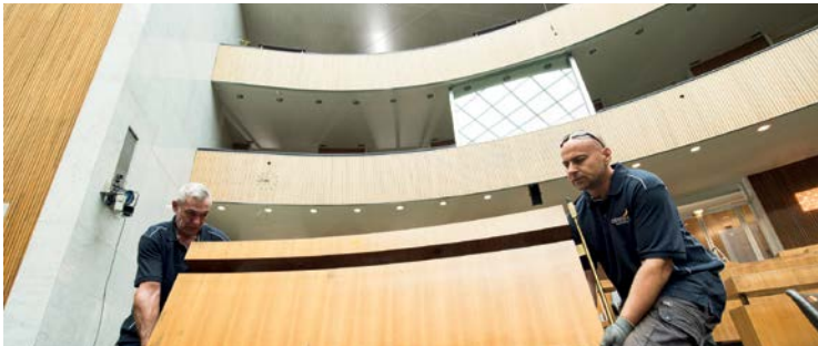
Abbau des Inventars im Plenarsaal des Parlamentsgebäudes
