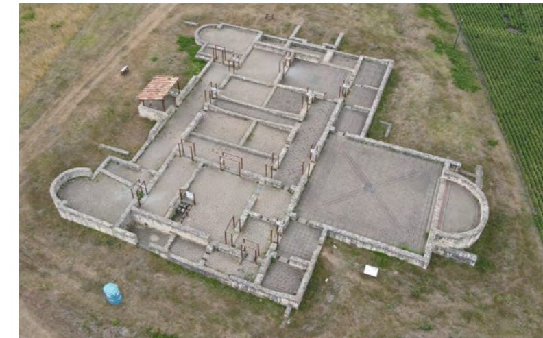
Palastvilla in Bruckneudorf, Drohnenaufnahme Foto: © Burgenland Archäologie
